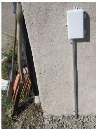
Skarvbox – Utomhusmonterad Mått: HxBxD 21 x 14 x 4 (cm)
